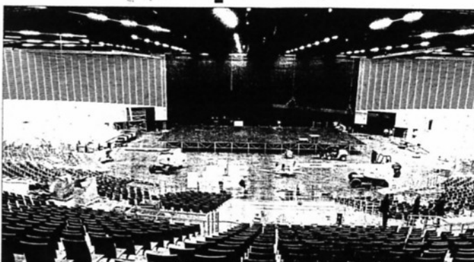
CHANTIER. Il est presque terminé. Reste à assembler un escalier d'environ 11 m de haut à poser, quelques portes, lavabos et sanitaires, et à monter les rideaux de scène très fragiles.
