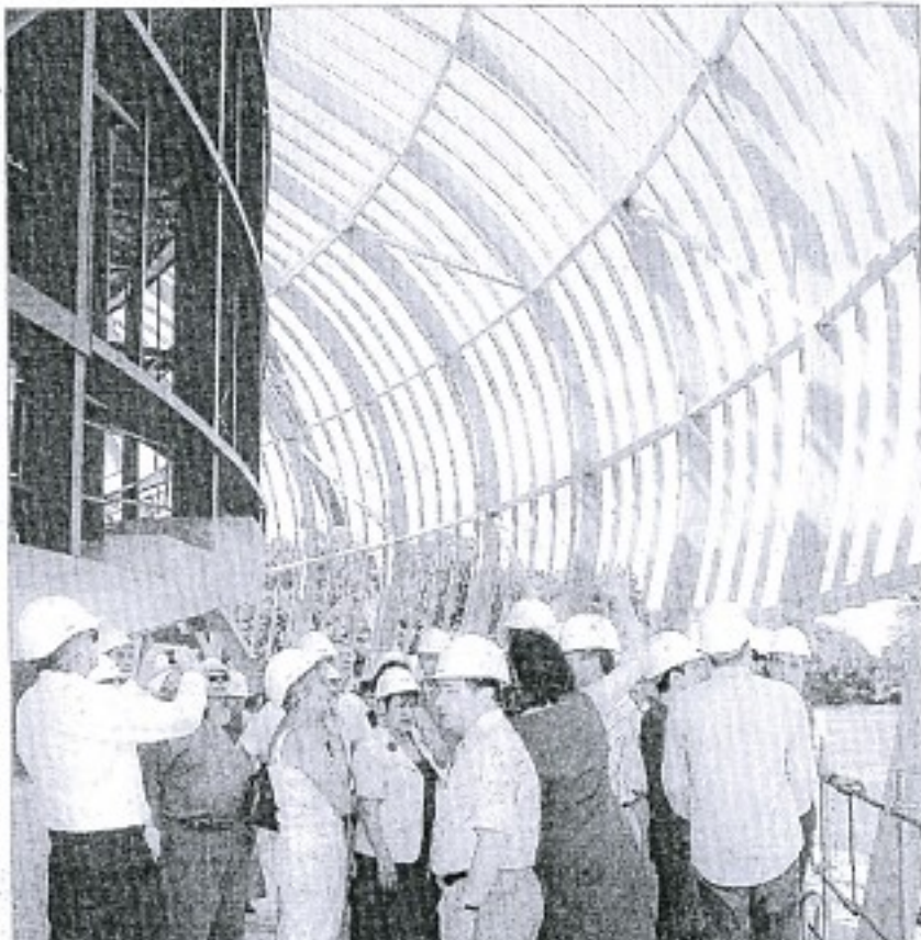
VISITE DE CHANTIER. Le bois, notamment du douglas limousin prend une part prépondérante dans la conception du Zénith.
